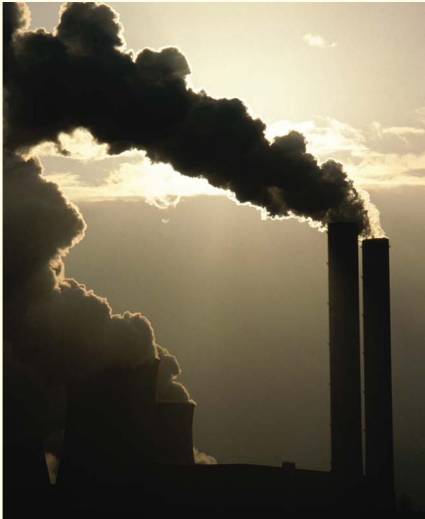
Foto acima: Processo de combustão usando óleo combustível, descontrolado por falta de ar, gerando uma grande quantidade de fuligem.
